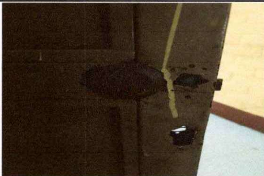
Foto 11: PUERTAS DE METAL SUSTITUCIÓN DE CHAPAS EN 5 PUERTAS.
